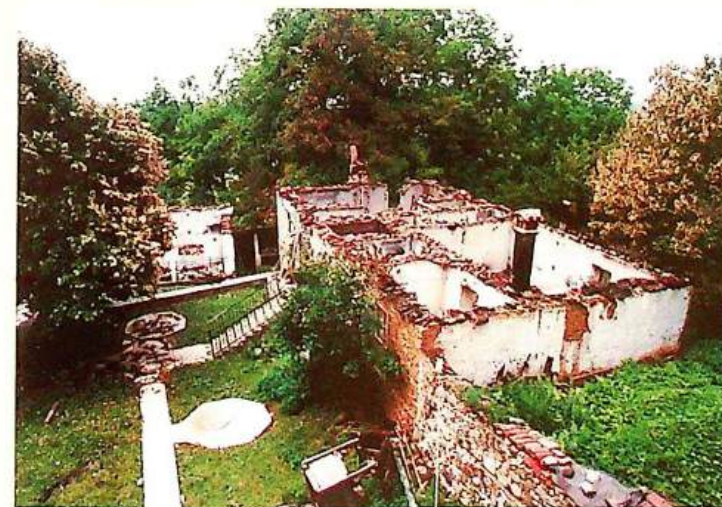
The parish house destroyed by fire / Запаљени парохијски дом
