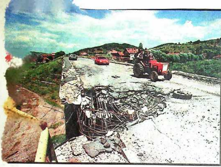
● De weg van Pristina naar Mitrovica: een door de NAVO getroffen brug.
