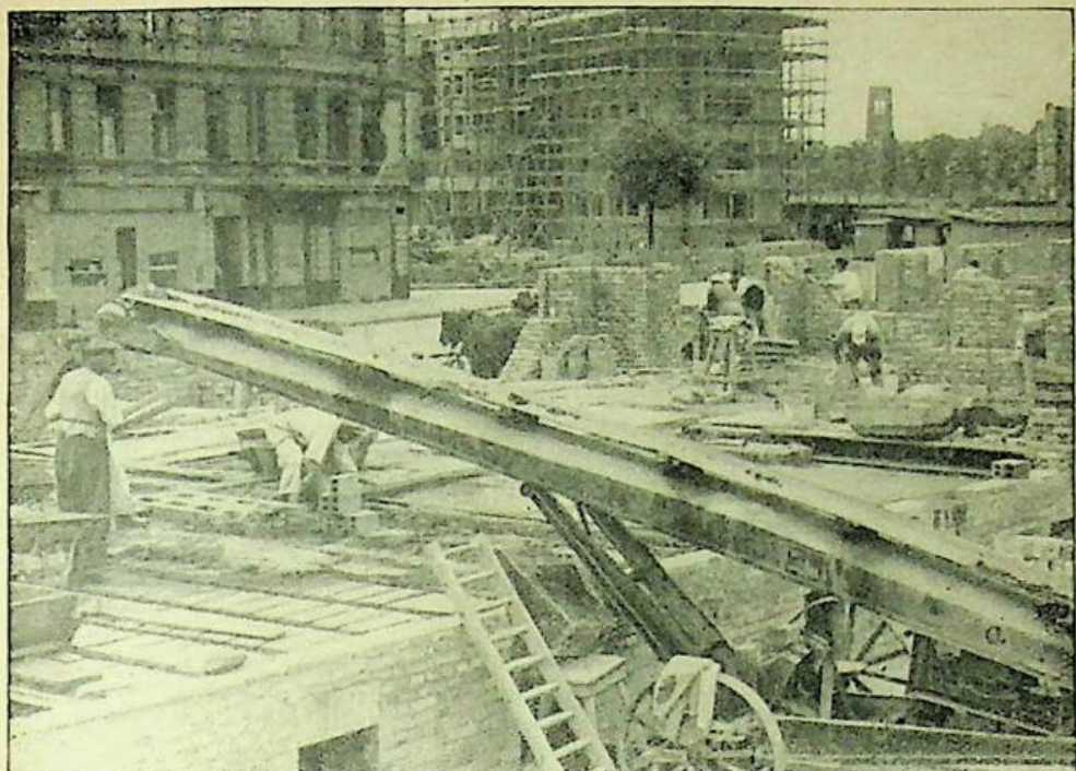
Beim Bau der Wohnblöcke in der Stalinallee in Berlin wurden neuartige Baumethoden angewandt.
