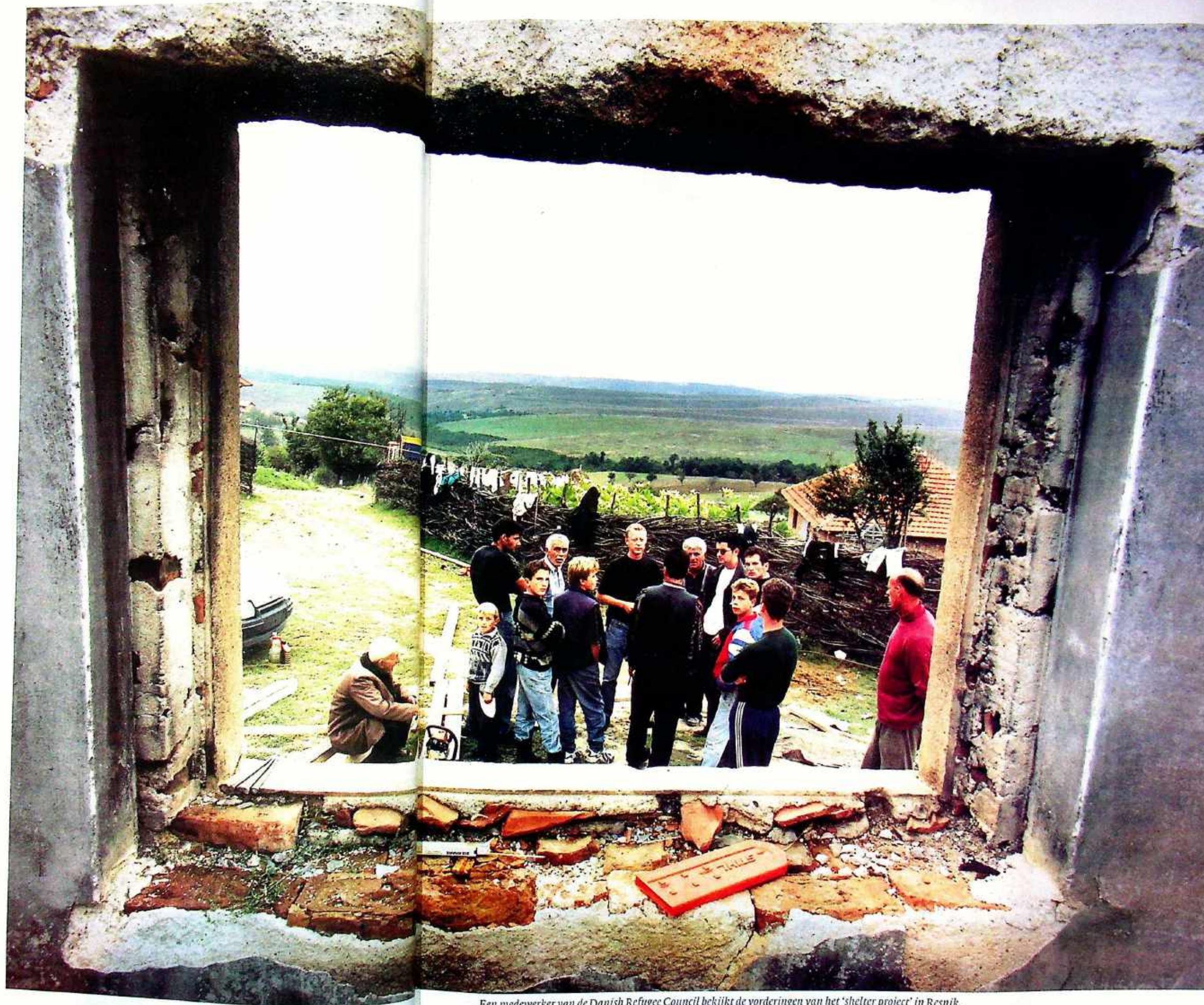
Een medewerker van de Danish Refugee Council bekijkt de vorderingen van het 'shelter project' in Resnik.
