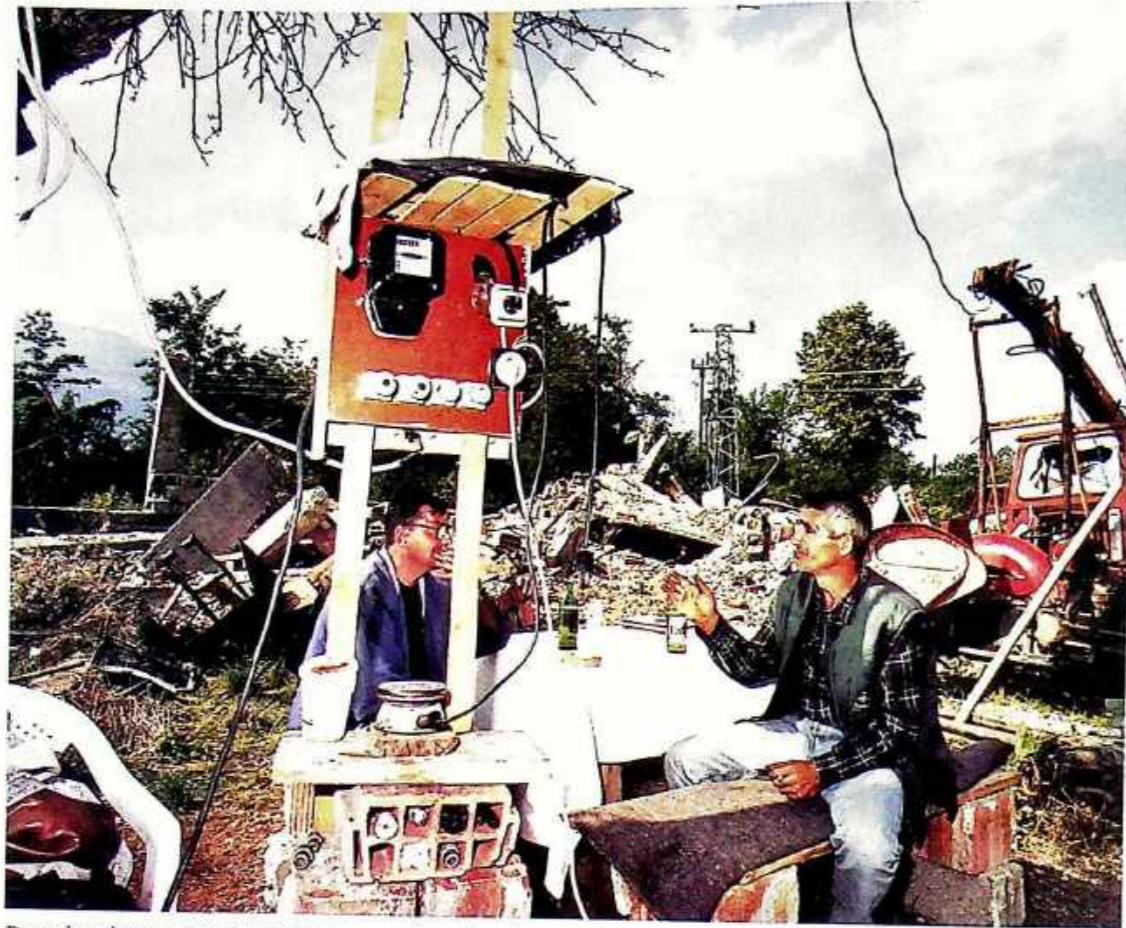
De wederopbouw in Loxaha. Albanzen voeren herstelwerkzaamheden uit.
